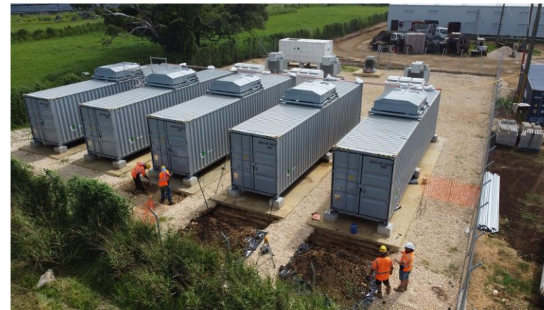
BESS centralisé: 7MW/24MWh aux Tonga
