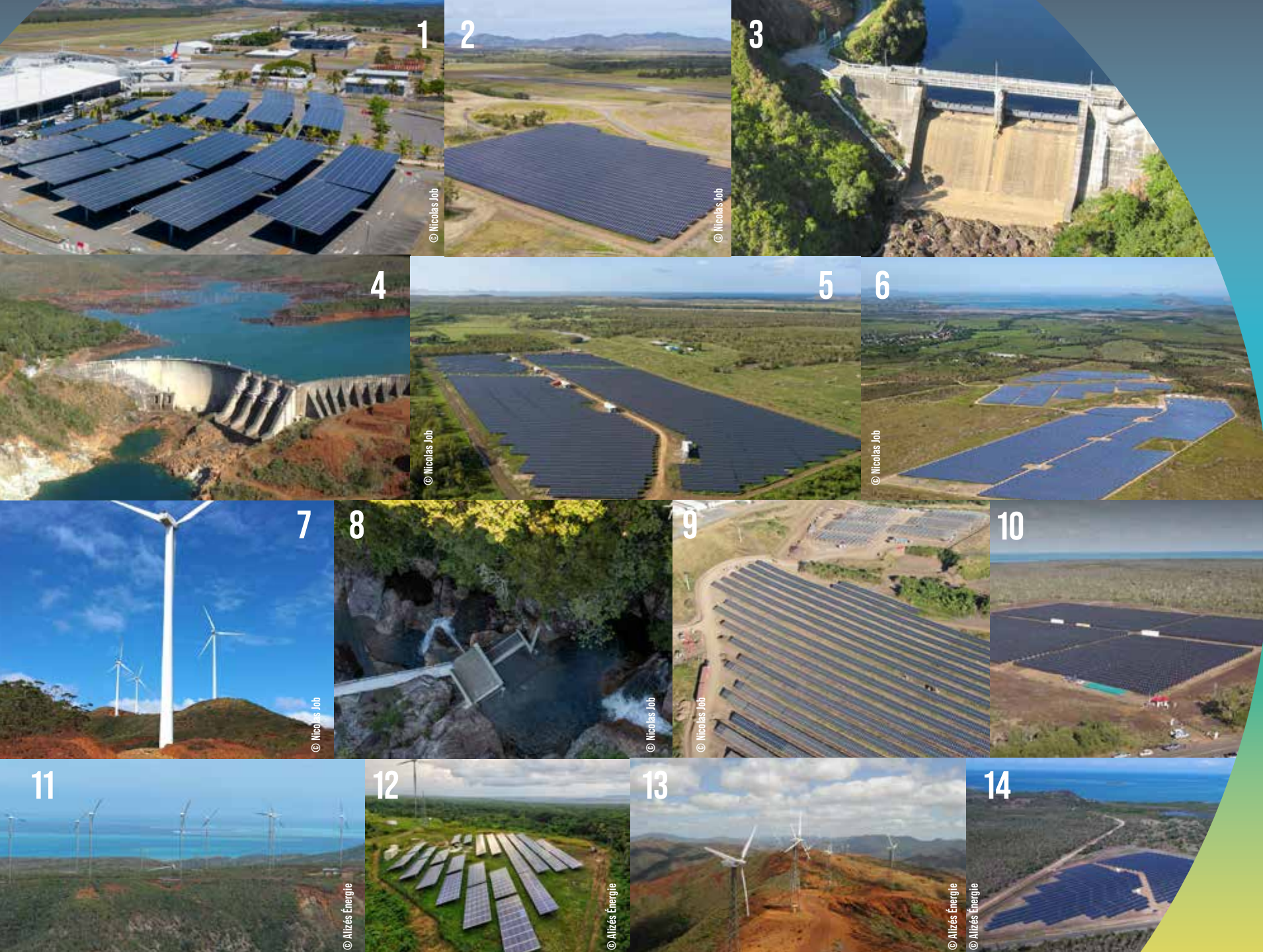
1 - OMBRIÈRES TONTOUTA - 2 - CENTRALE HÉLIO TONTOUTA - TotalÉnergies : 5 GWh/an pour sol+ombrières - 3 - NÉAOUA - ENERCAL : 306GWh/an - 4 - YATÉ Enercal : 307 Gwh/an - 5 - WI HACHE OUATOM Enercal : 13 Gwh/an - 6 - HÉLIO BOULOUPARIS 1 Totalénergies : (16 GWh/an) & 2 (24,5 GWh/an) - 7 - EOLE YATÉ - Totalénergies : 45 GWh/an - 8 - HYDRO PAALO - ENERCAL : 7 Gwh/an - 9 - OUACO - Enercal : 7 GWh/an - 10 - HÉLIO PLAINE DES GAÏACS : Totalénergies 10,5 GWh/an 11 - ÉOLIEN KAFEATE VOH - 9.5 GWh/AN - 12 - PV ET ÉOLIEN LIFOU : 0,5 GWh/AN - 13 - ÉOLIEN NEGANDI PLUM : 2.9 GWh/AN - 14 - PV TANGADOU KOUMAC : 5.4 GWh/AN
