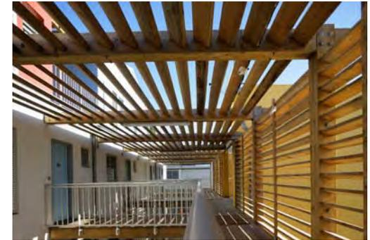
Brise-soleil pour protection d'une façade béton faisant office de tampon thermique
