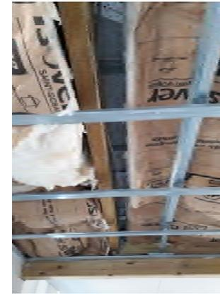
Mauvaise mise en œuvre d'isolant thermique sous toiture
